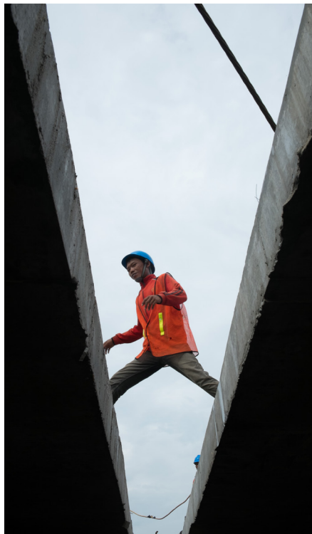
Gambar (Illustration) 07. Pembuatan Jalan Layang/ Fly Over Construction
