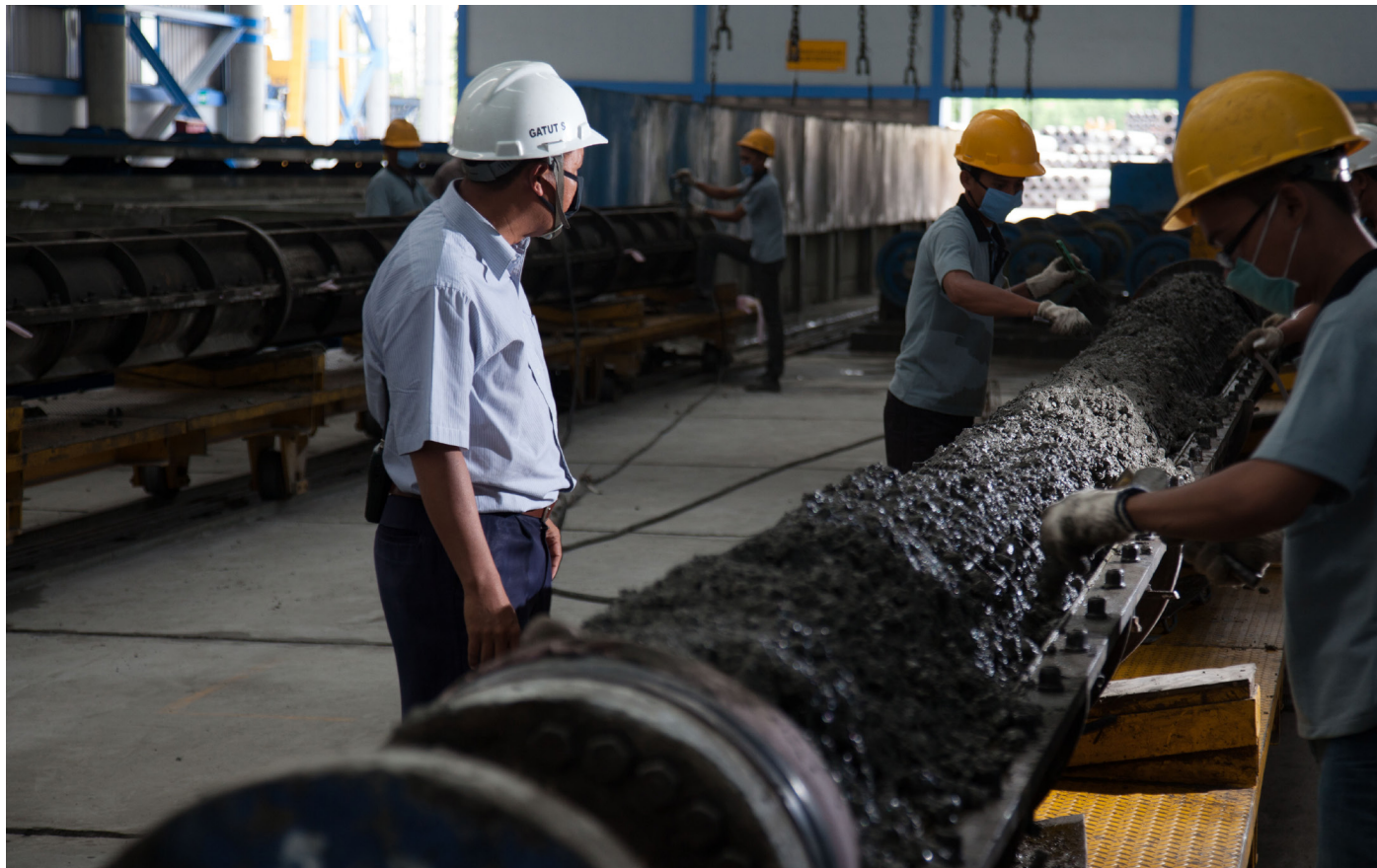
Gambar (Illustration) 10. Pembuatan Tiang Pancang/PC Piles Production
