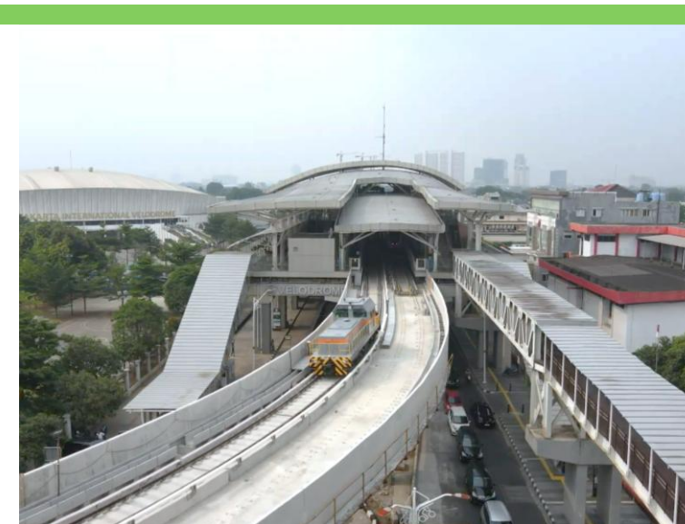
LRT Jakarta Fase 1B Velodrome - Manggarai
